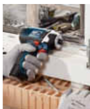
Pose de fenêtres
