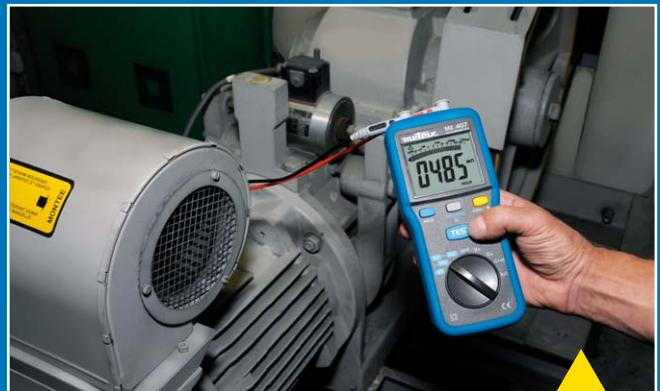
Mesure d'isolement sur un moteur dans le cadre d'une maintenance préventive
