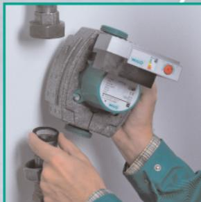
Mettez en place la nouvelle pompe avec les joints neufs et vissez
