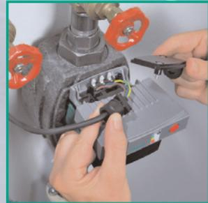
Ouvrez le couvercle de la boîte à bornes, introduisez le câble par le presse-étoupe PG placé indifféremment à gauche ou à droite et raccordez les fils grâce au borieur Clip-On.
